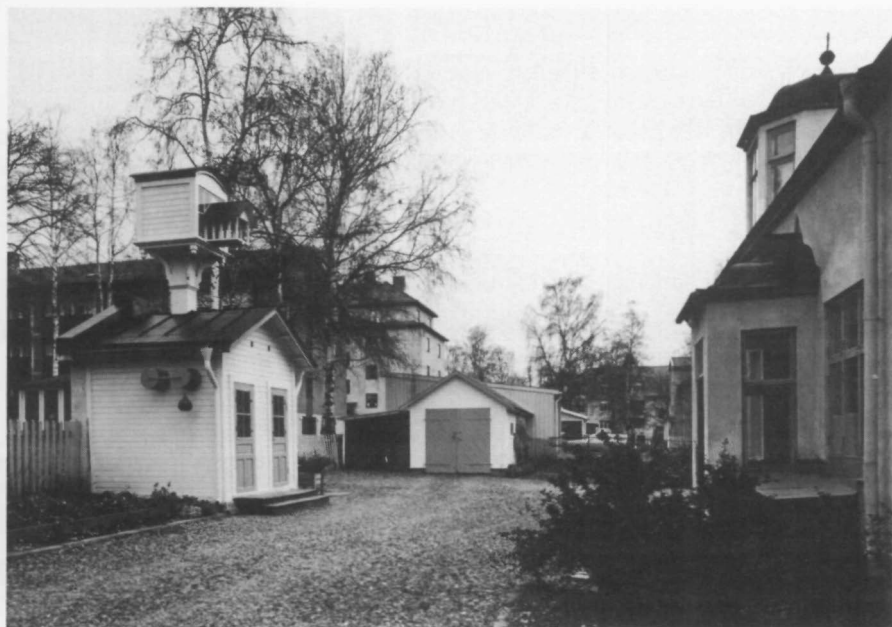
Östra sidan med fågelhus, garage och köksingång. Foto 1989 A Halling.
