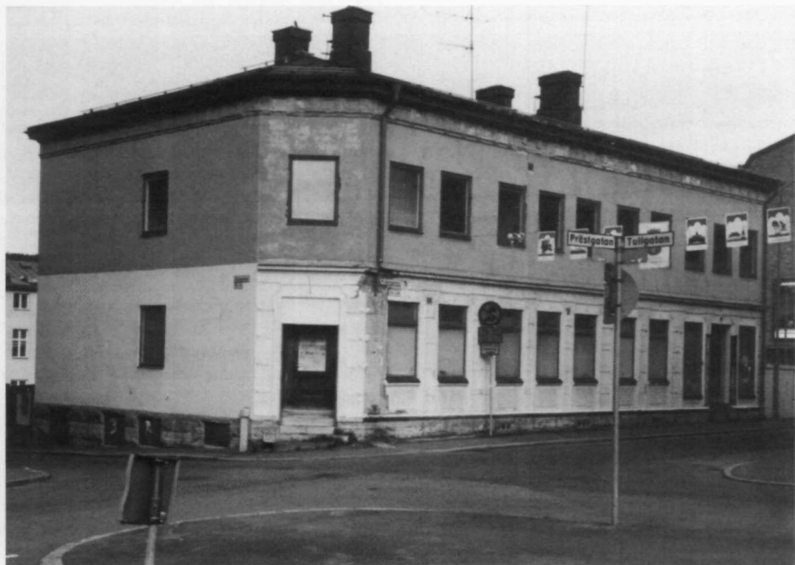
Gunnar Fastborgs barndomshem på Prästgatan 54. Byggnaden uppfördes 1895 och förändrades något 1944. "Nu skall 54:an rivas, nu skall 54:an bort ..."
